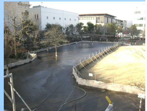
M S Cが混合攪拌された濁水は、処理ヤードに放出され、速やかに疎水分離されます。M S Cの無臭化作用により、工事中も一切の悪臭はありません。
