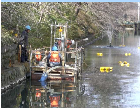
台船にセットされた攪拌ポンプにて底泥を攪拌し、浚渫ポンプにて高濃度の泥水を吸引します。
