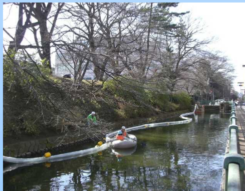
泥水は送泥配管にて処理プラントへと送られます。浚渫船の移動に対応するよう水上部はフロートにて浮上設置、地上部は安定した金属配管を敷設します。
