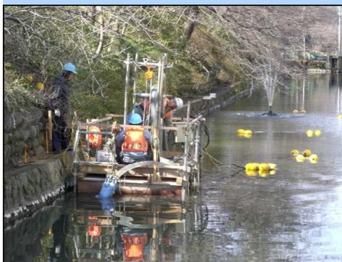
用安置在台船上的搅拌泵来搅拌底泥，用疏浚泵来吸引高浓度的泥水。
