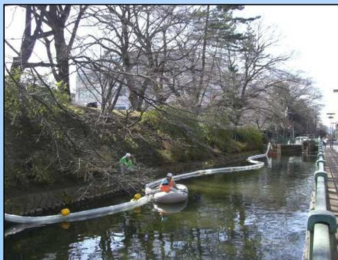
泥水是用送泥配管送到机械设备里。为了能适应疏浚船的移动，水面上用浮筒浮起来，地面上铺设稳定的金属配管。
