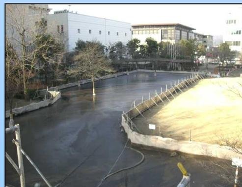
把M S C混合搅拌的浑水放到处理场里，可很快的脱水分离。利用M S C的无臭化作用，施工过程中不会产生任何的恶臭味。
